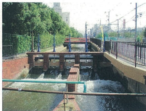
二俣樋門：玉串川
